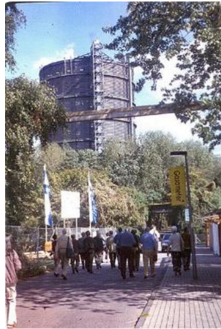
Fig. 3 The Oberhausen Gasometer, Ruhrgebiet.
