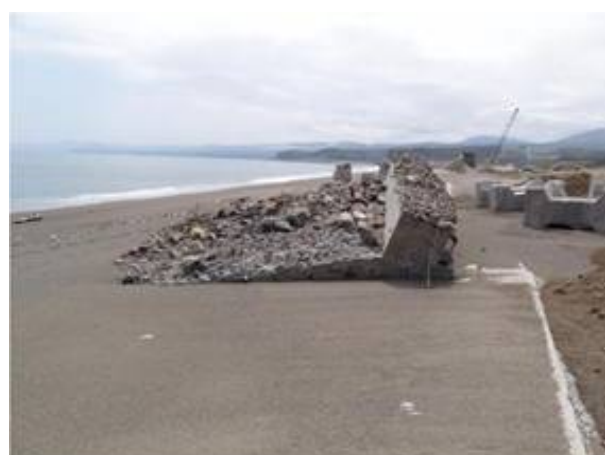
Fig. 5 Collapsed tide wall (No. 1).
